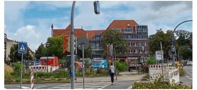
Hier wird der neue Kreisverkehr gebaut. FOTO: HANSESTADT UELZEN
